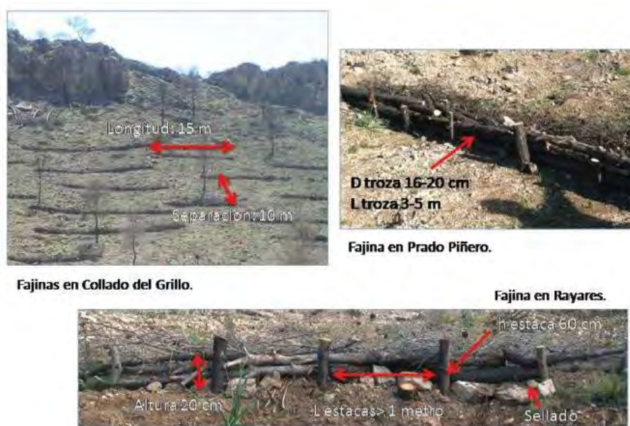
Figura 4 Criteris constructius (D=diàmetre; L=longitud; H=altura)
